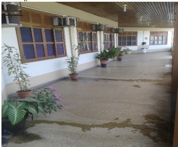
Figura 11: Fachada de acesso ao interior do CREAP.
