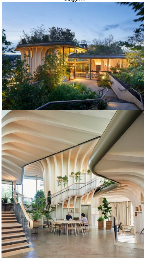
Figuras 1 e 2 – (a) Fachada frontal e (b) vista interna da instituição Maggie's.
