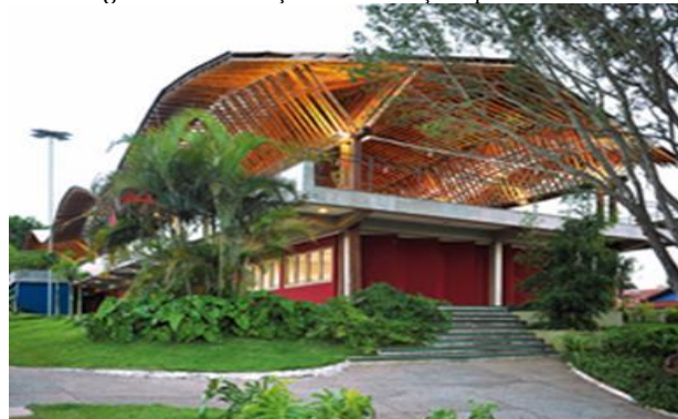
Figura 02 – Utilização de edificações preexistentes
