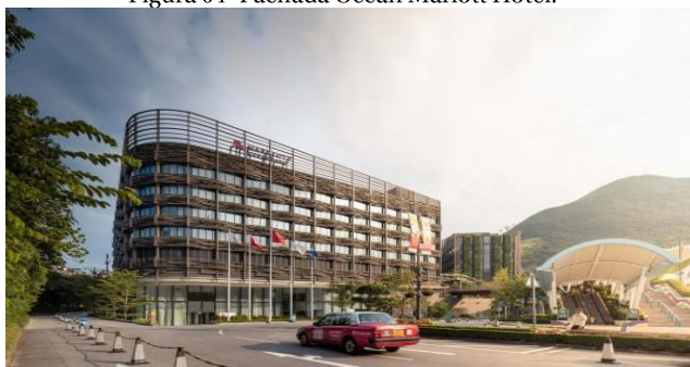
Figura 04- Fachada Ocean Marriott Hotel.
