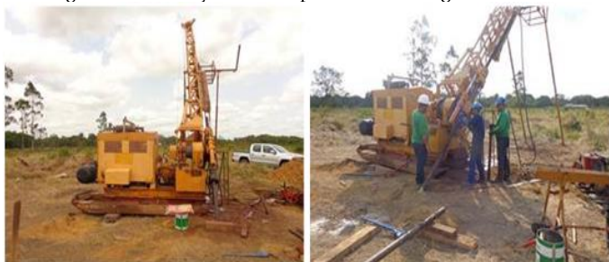
Figura 3 - Realização da Campanha de Sondagens Rotativas.
